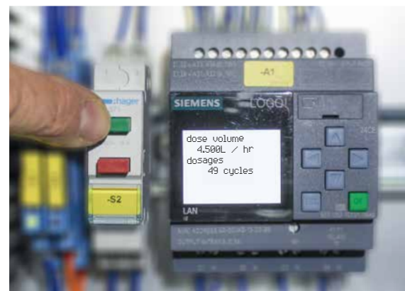
Setting Dosing „green“ + 25 ml/h „red“ - 25 ml/h
